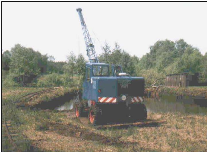
*Oben der „leichtfüßige“ Bagger in einem Bild aus den 1960er Jahren, unten der bereits deutlich größere Fuchs-Bagger im Jahr 1976. Deutlich sichtbar sind die Holzplanken zur Absicherung gegen das Einsinken der Räder. Links die Gleise der Moorbahn, rechts im Schuppen die Grundwasserpumpe.*
